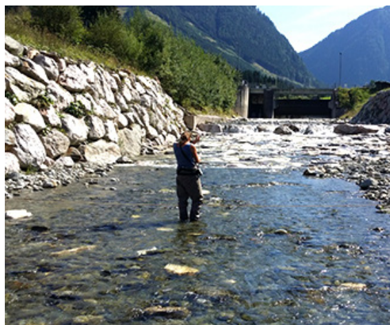
*Abb.2: Restwassermessung an einem KW im Bezirk Liezen; Zweitüberprüfung mit konsensgemäßer Pflichtwasserabgabe
