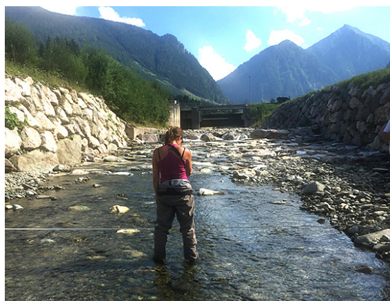
*Abb.1: Restwassermessung an einem KW im Bezirk Liezen; Erstüberprüfung mit deutlicher Unterschreitung der Pflichtwassermenge
