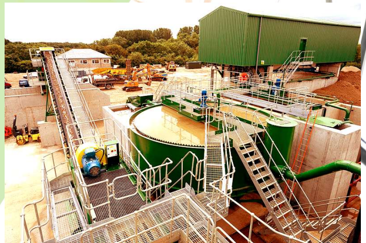
Trennung von Bau- und Abbruchabfällen in einer Recycling Anlage
